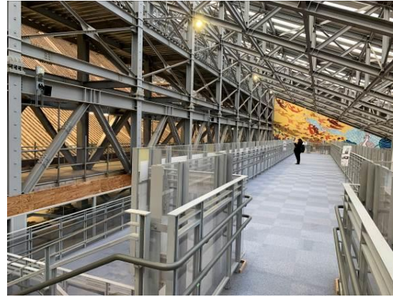
圖 27 整修棚架內部搭建「見學走廊」 可近距離觀看修復工藝
