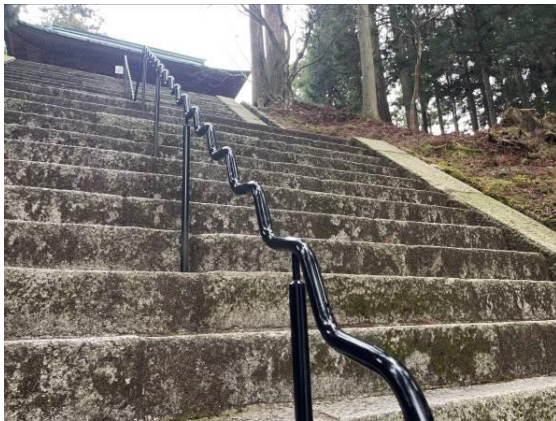
圖 28 延曆寺內陡梯以波浪狀扶手方便 使用者上下階梯
