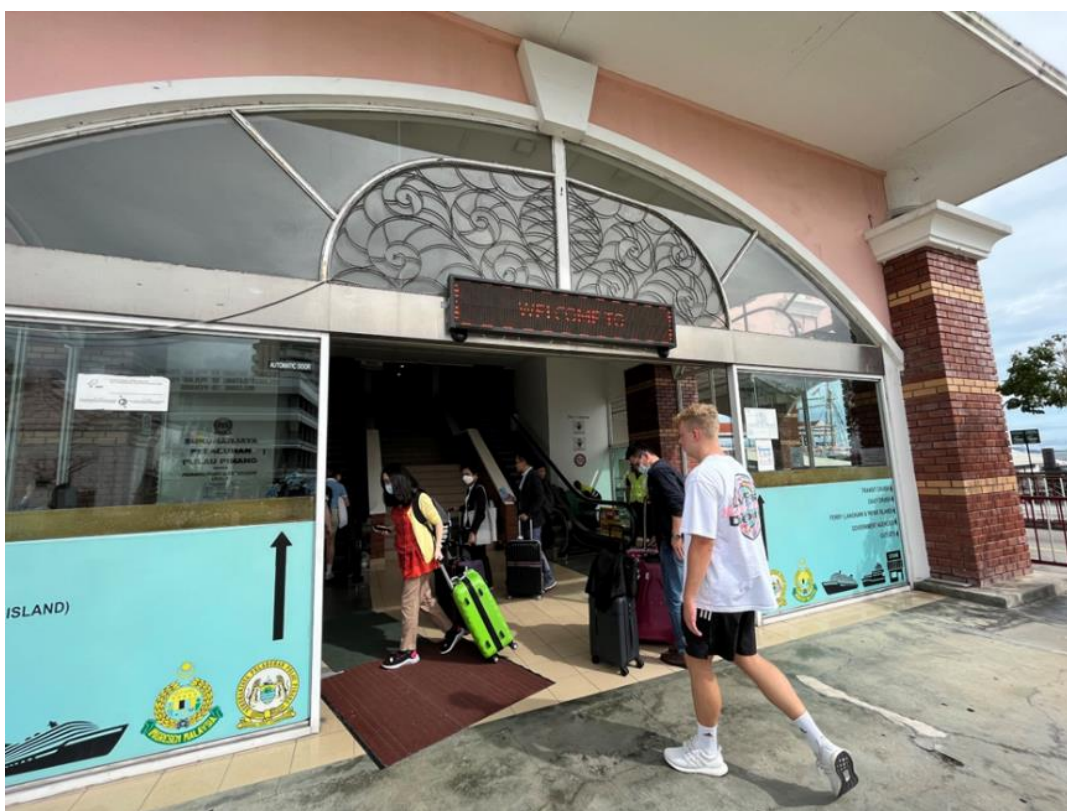
圖 1、Swettenham Pier Cruise Terminal 旅客中心 1 樓入口
