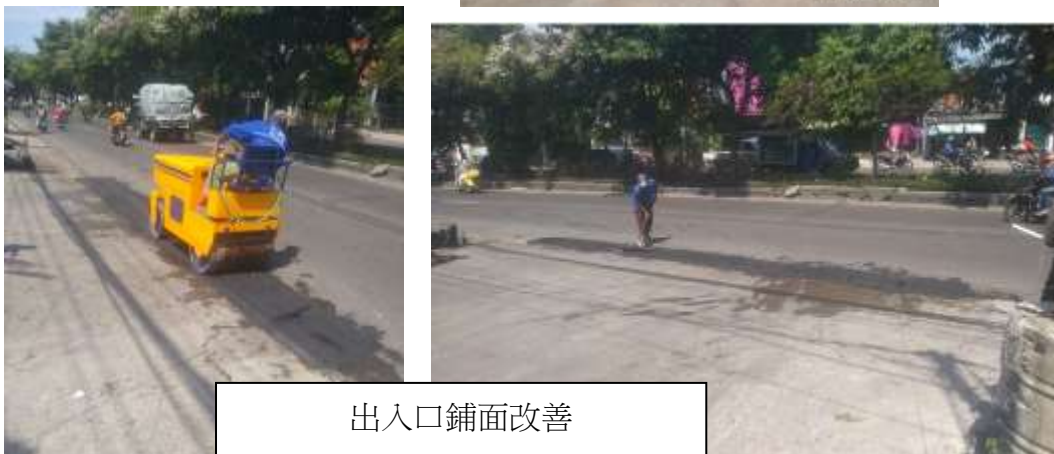
圖 6: 場地及道路鋪面修護
