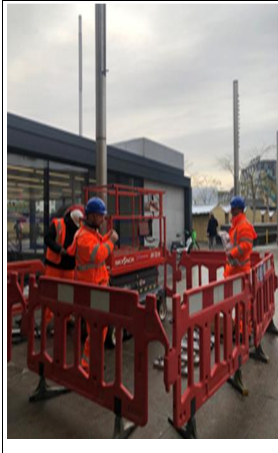
圖 3.4.7 施工區域管制
