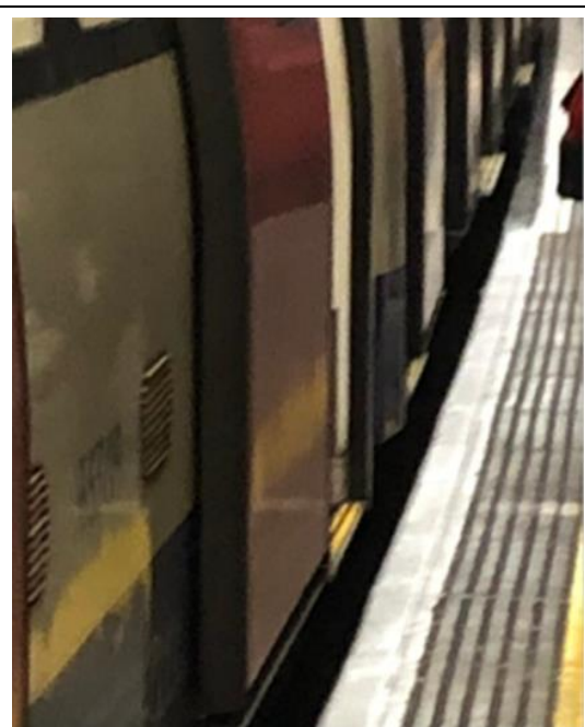
圖 3.4.17 以部分增高來解決月台與車廂高低落差
