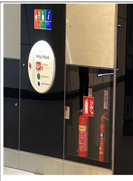
圖 3.4.24 求救系統、詢問系統及緊急應變火災系統整合
