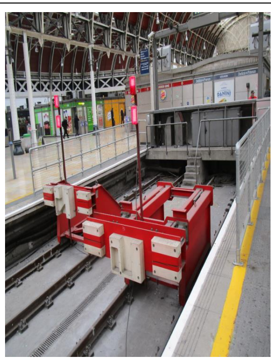
圖 3.3.16 帕丁頓車站月台末端止衝擋
