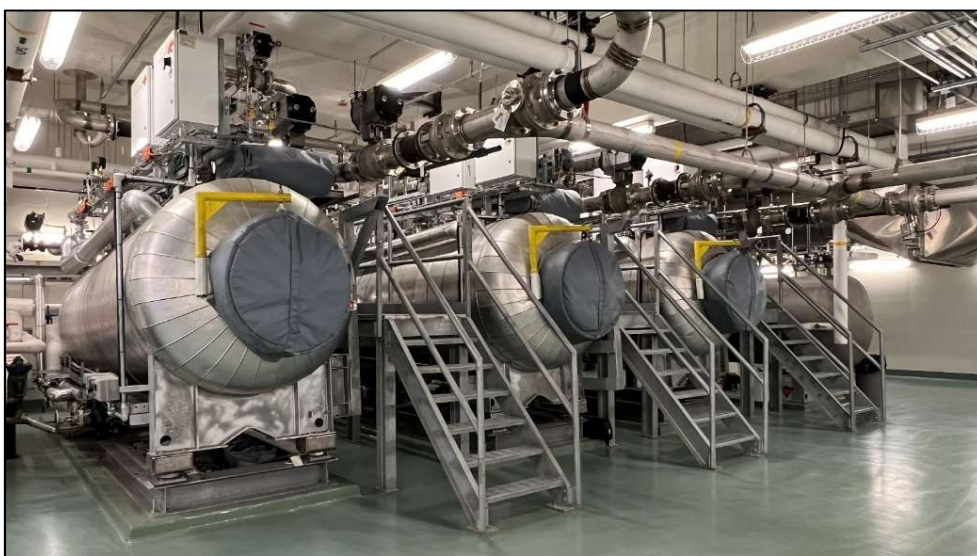
圖四、感染性廢水處理系統(EDS) (摘錄自課程講義)
