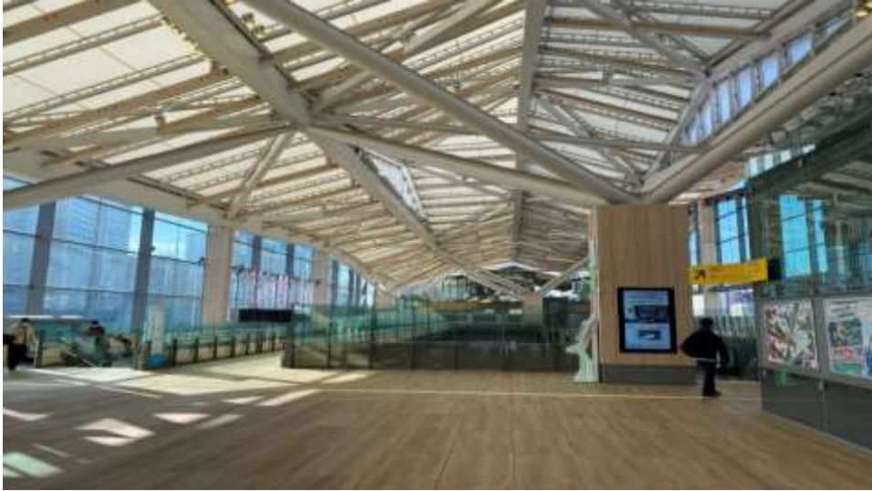
圖 3.7.2 高輪車站站內建築
