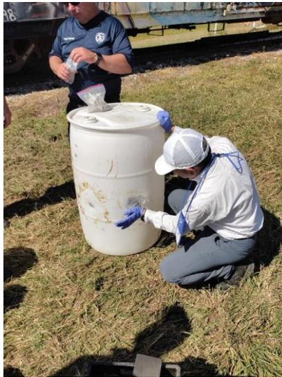
圖 12. 使用固化劑填塞 53 加侖橡膠桶破裂處
