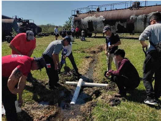
圖 19. 利用 PVC 管築堤引流
