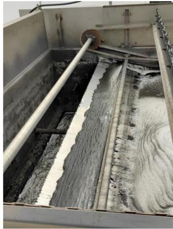
圖 72. 廢水收集及表面泡沫污泥處理系統
