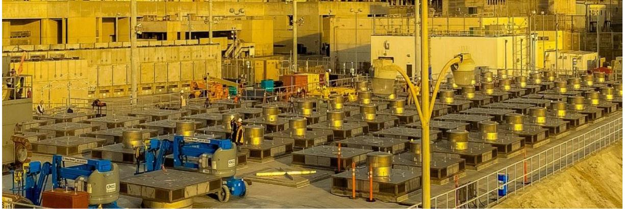
圖三（三）5、 San Onofre 電廠 HI-STORM UMAX 乾貯系統
