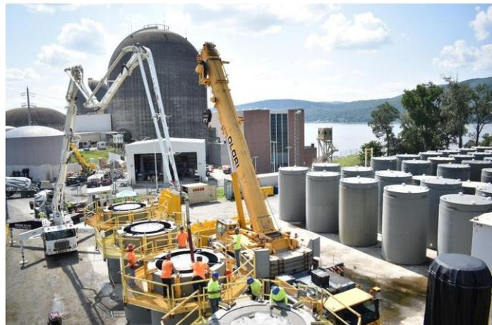
圖三（一）9、混凝土護箱澆製
