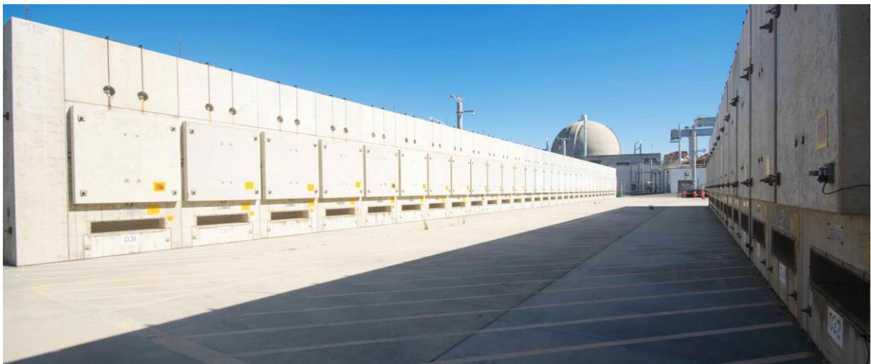
圖三（三）4、 San Onofre 電廠 NUHOMS 乾貯系統
