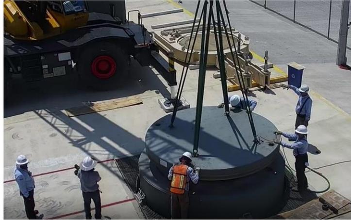
圖三（二）6、密封鋼筒轉換坑內作業
