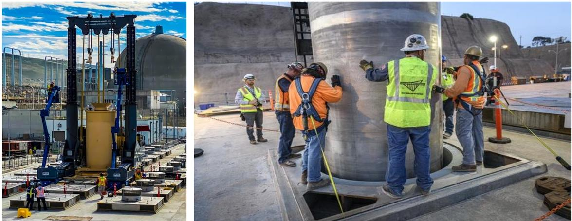
圖三（三）6 及 7、 HI-STORM UMAX 運貯作業
