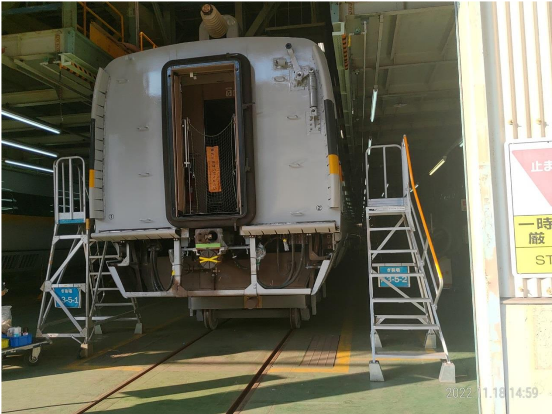
維修用移動式工作高台底部支撐移動/固定設計
