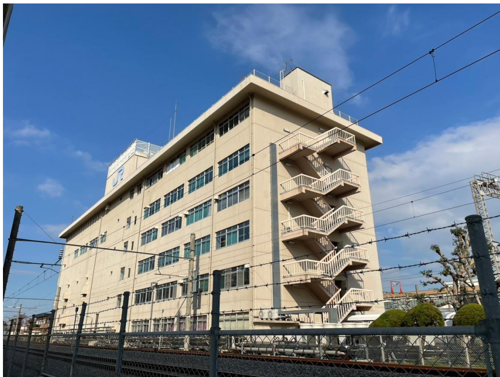
JR 西日本博多綜合車輛所
