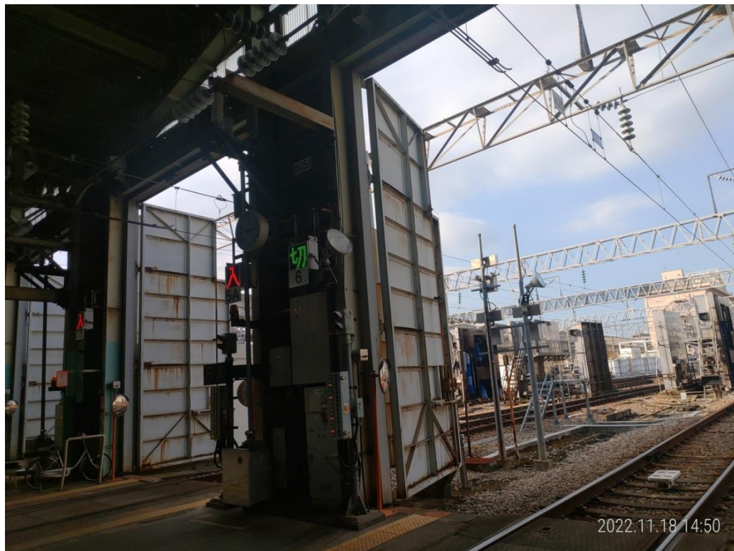
列車維修庫每股道均設有自動洗車機，列車營運前均經洗車作業
