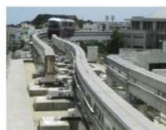
沖縄都市モノレール 株式会社殿納 モノレール分岐装置 Turnout Device of Straddle Type Monorail Track for Okinawa Urban Monorail, Inc.
