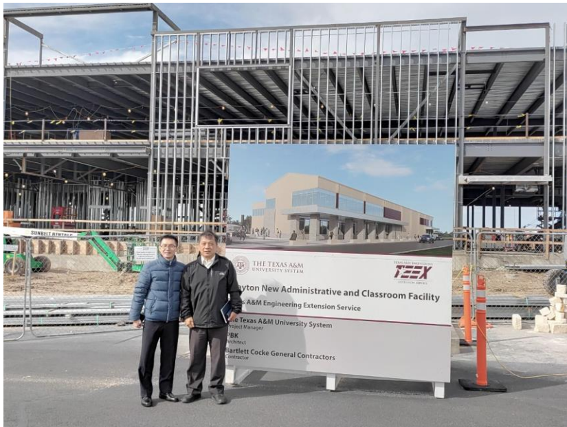
TEEX 的訓練場新建教室之工程。
