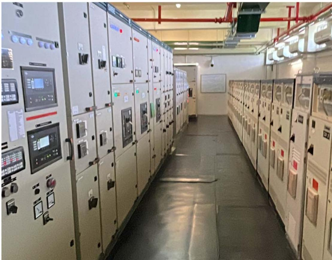
圖 4.6 配電盤及恆流變壓器 CCR
