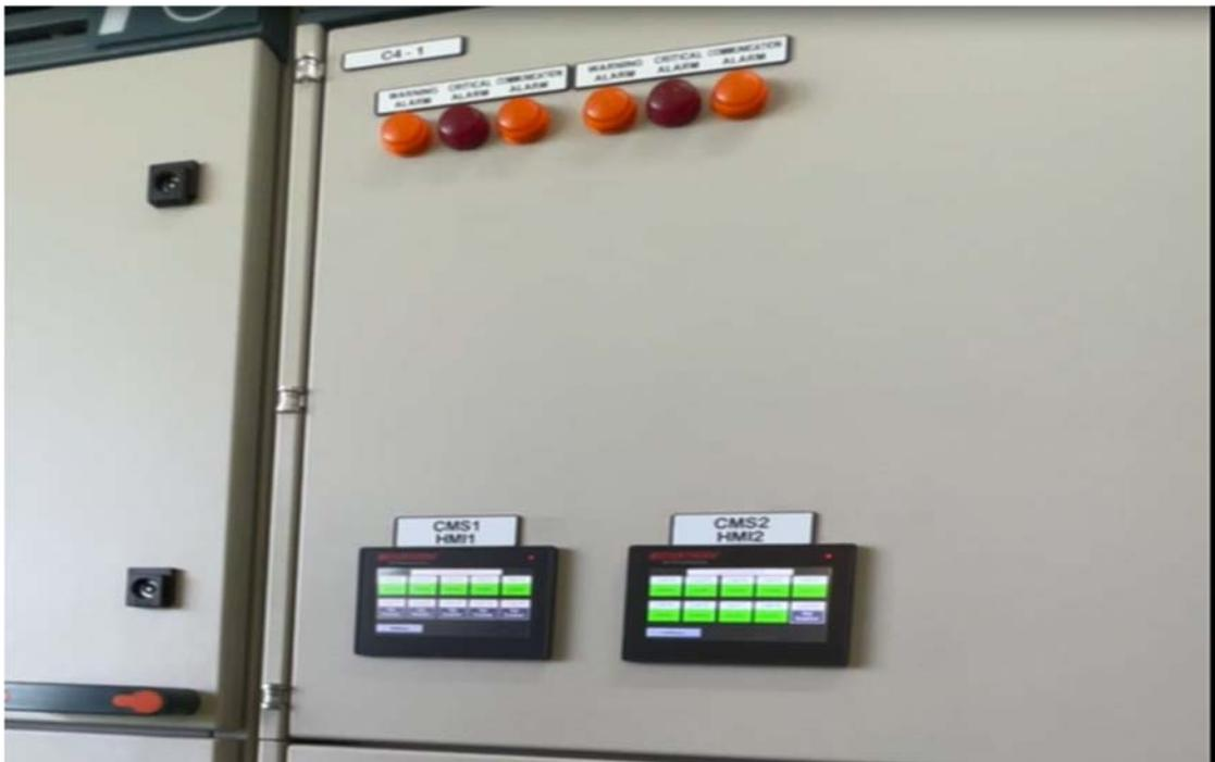
圖 4.2 低壓配電設備關鍵點溫度監測裝置
