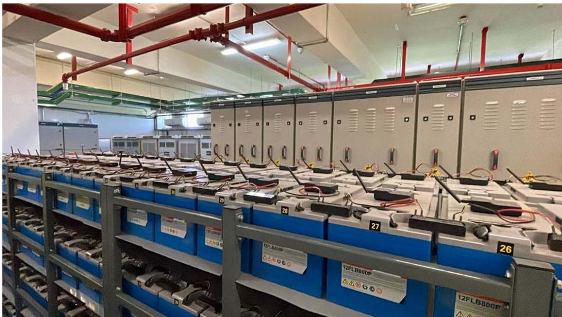
圖 4.4 靜態不斷電系統 On line 監測
