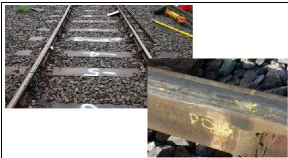
圖 27 車輪於鋼軌上的痕跡
