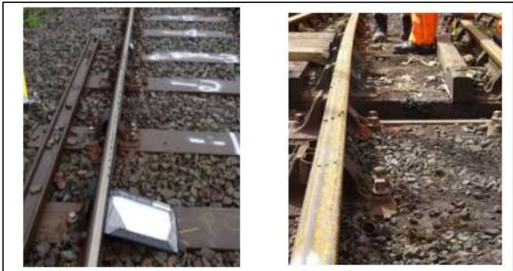
圖 26 車輪輪緣於鋼軌上之短標記
