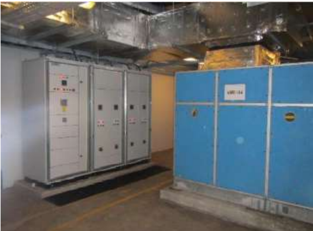
圖 61 隧道通風系統控制箱
