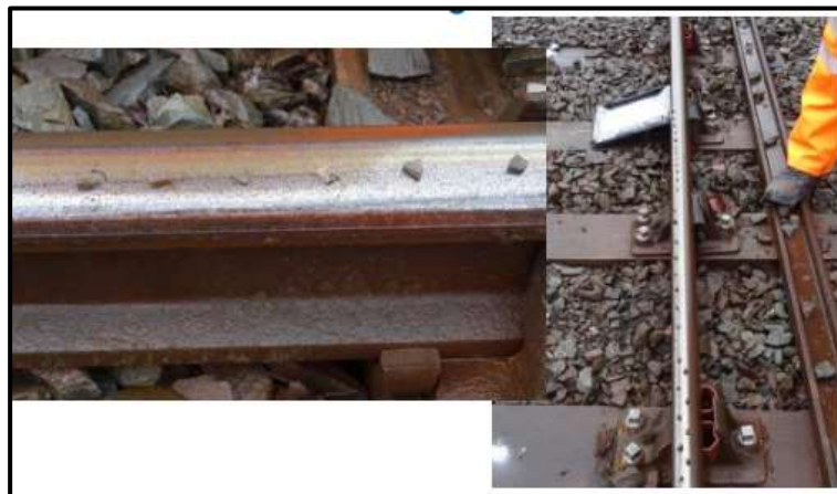
圖 25 車輪輪緣於鋼軌上之長標記
