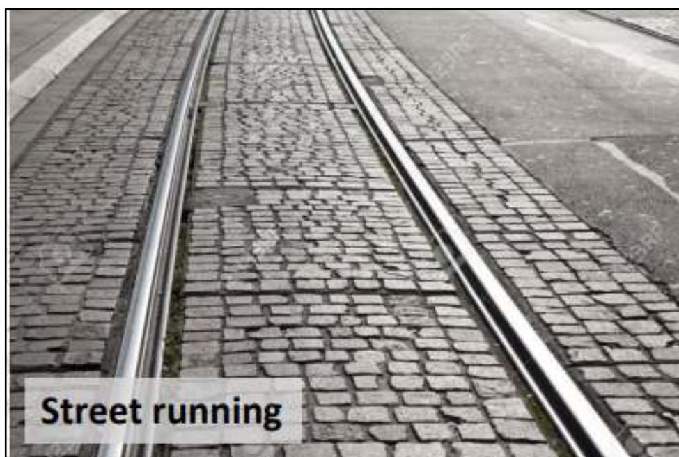
圖 45 輕軌軌道與一般路面混合使用
