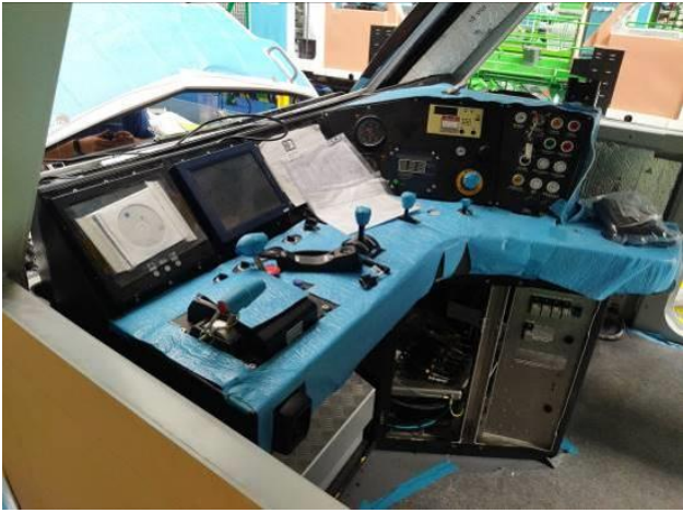
施工中駕駛室
