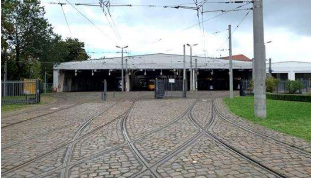
圖 10 萊比錫輕軌 Angerbrücke 四級檢修車輛機廠
