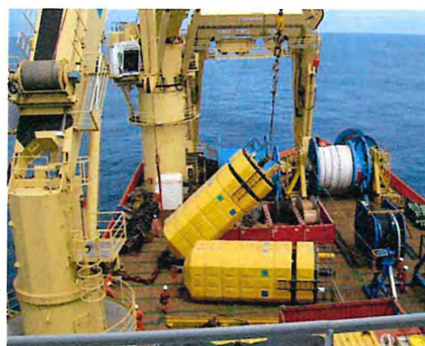
圖 7：海纜保護系統安裝
