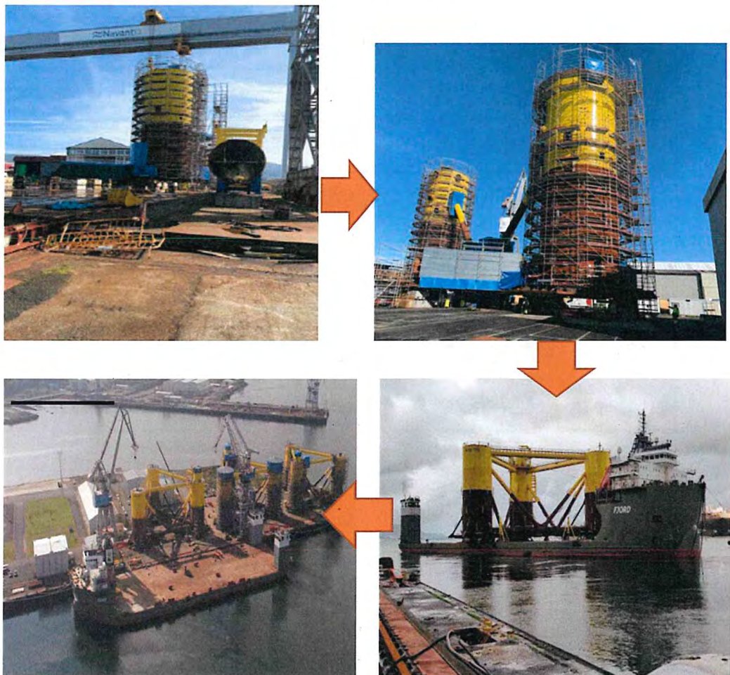
圖 1：Floating 製造、Load In 及 Load Out
