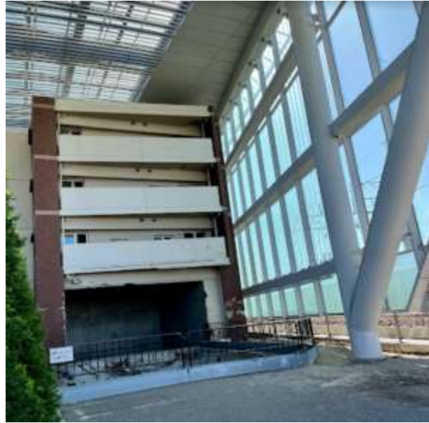
圖 1.4 福知山線出軌事故部份保存的被撞擊公寓
