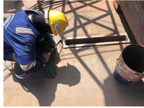
眼板盒焊接前開槽
