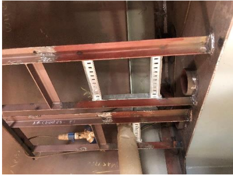
駕駛室配電盤架施作
