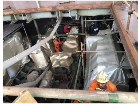
設備安裝後保護工作
