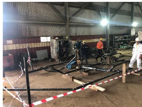
管路壓力測試
