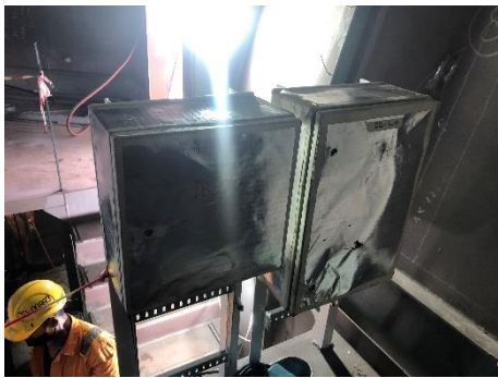
駕駛室配電盤安裝
