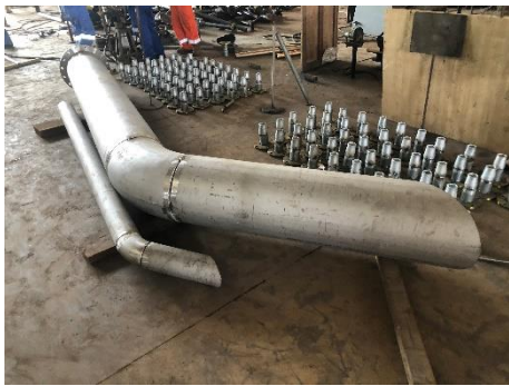
排煙管焊前檢查
