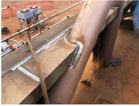
反拖牛角焊後檢查
