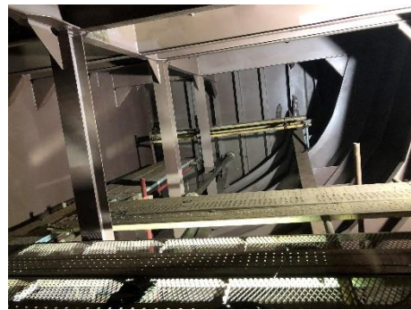
空艙塗裝施作
