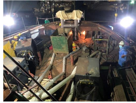
半夜船舶施工查驗
