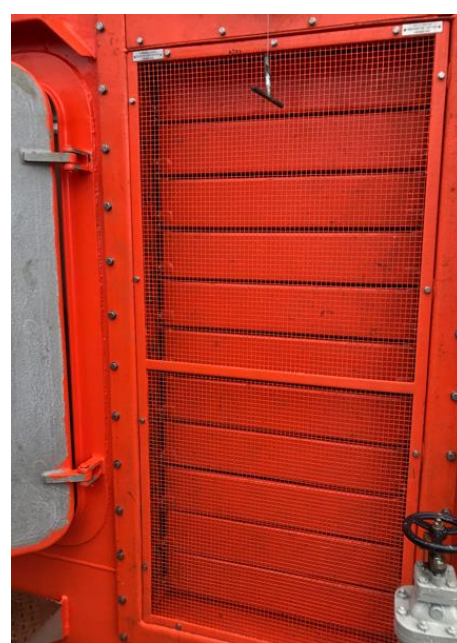
機倉通風百葉窗完工
