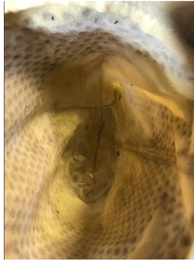
主機燃油管路清洗
