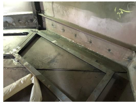
駕駛室控制盤底座安裝
