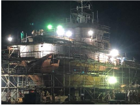
半夜船舶施工查驗
