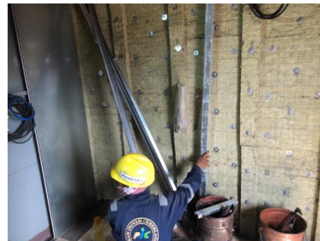
岩棉安裝及室裝板架安裝
