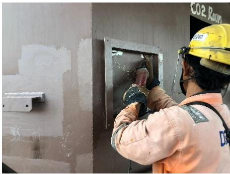
電箱座焊接前處理
