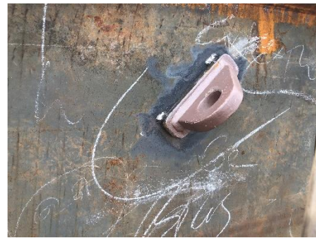
碰墊掛座焊接前檢查
