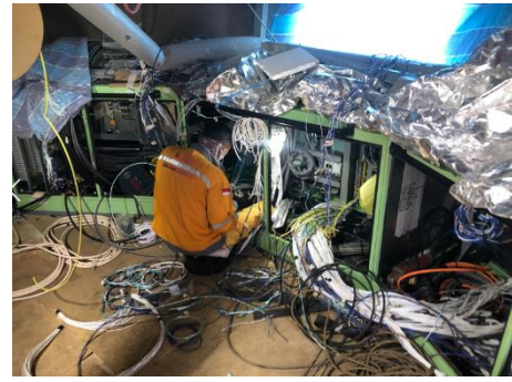
駕駛室控制盤配線
