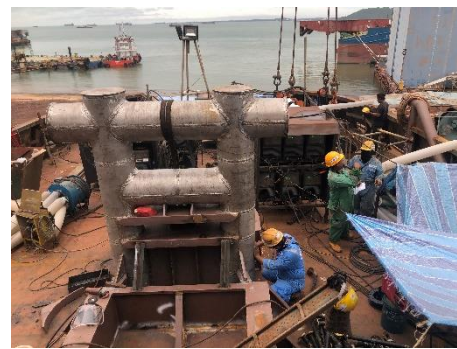
艏十字纜樁安裝於船體
