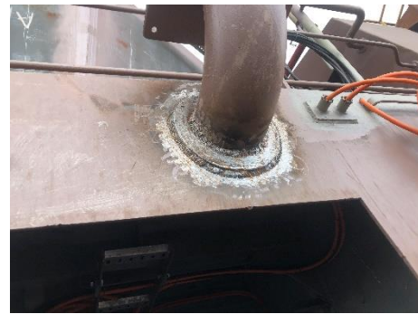
後絞機控制盤底座安裝
