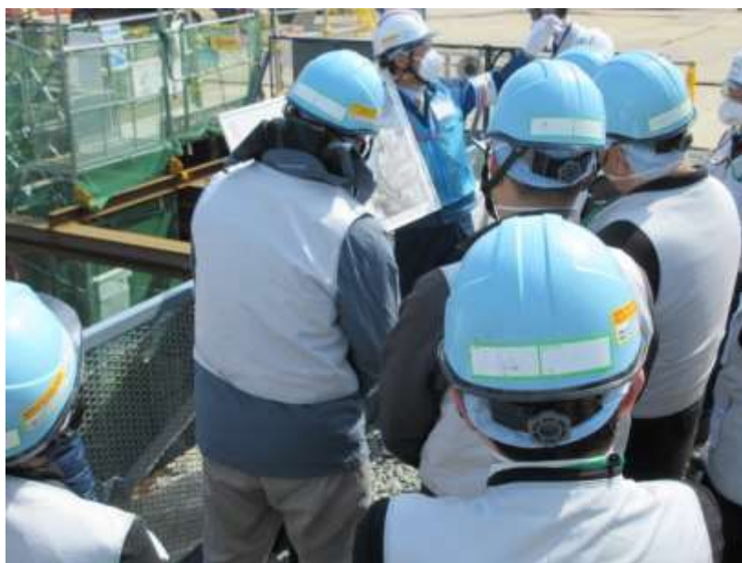
圖 7、ALPS 處理水之放水立坑施工情形說明。
