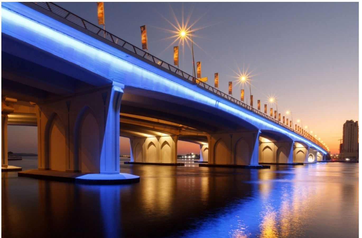
圖4 阿爾加胡德夜景 圖片來源： https://www.maxfrank.com/intl-en/projects/entries/Al-Garhoud-Bridge.php
