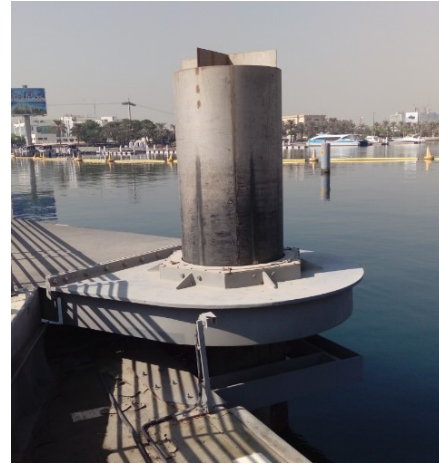
圖10 浮橋旋轉軸
