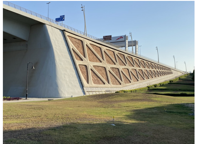
圖3 阿爾加胡德橋橋台
