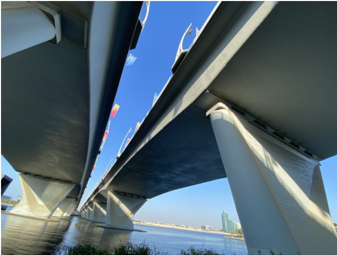
圖2 阿爾加胡德橋上構及壁式橋墩
