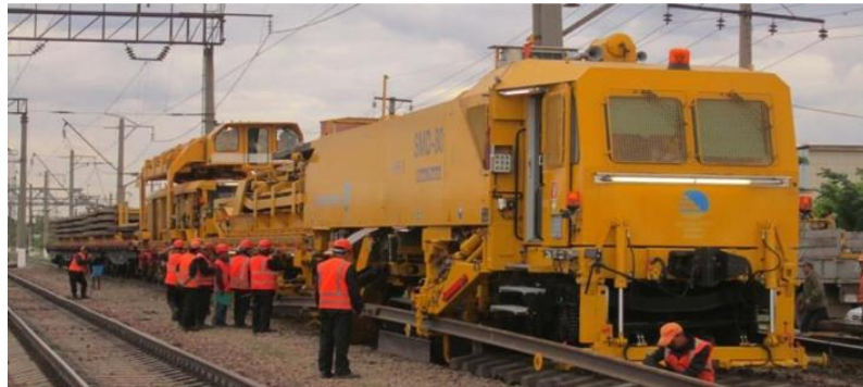
圖 5、軌枕更換機械施工作業車輛
