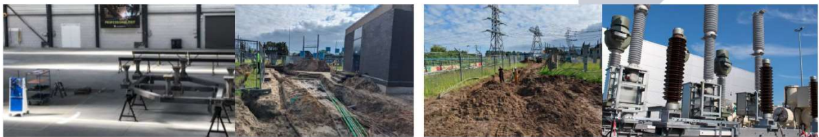
圖 3-1 TenneT 公司進行檔位層更換工程之進行方式
