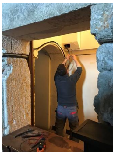
電源總電箱施作狀況
