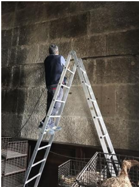
第2展場電源插頭及接線盒施作
