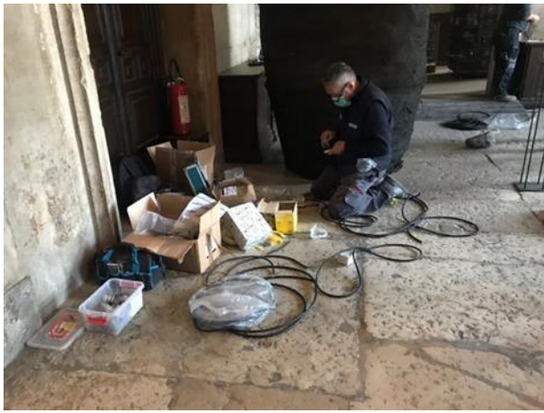
第1展場電源插頭及接線盒施作
