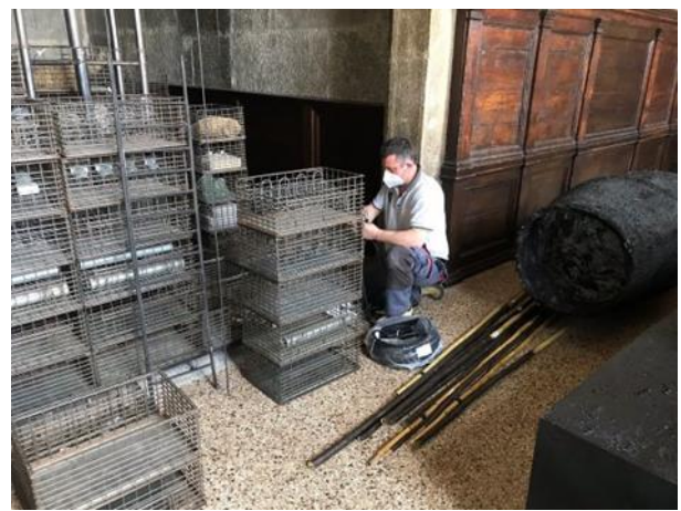
第2、3展場電源插頭及接線盒施作
