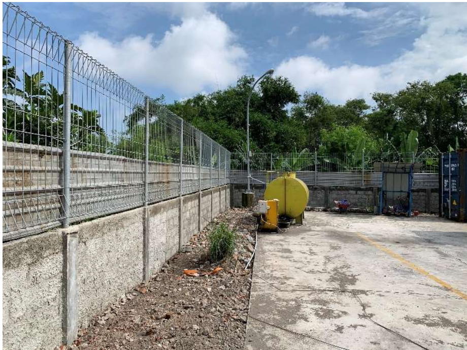
(圖四)圍牆修復完成情形
