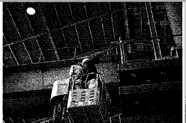
須檢查開度指示計是否與閘門開度吻合
