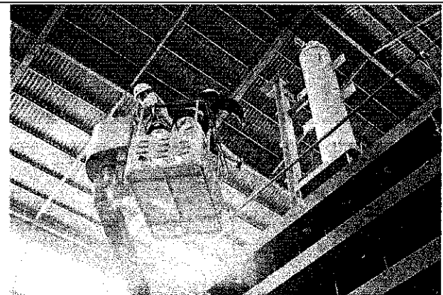
檢驗官檢查開度指示計是否與閘門開度吻合
