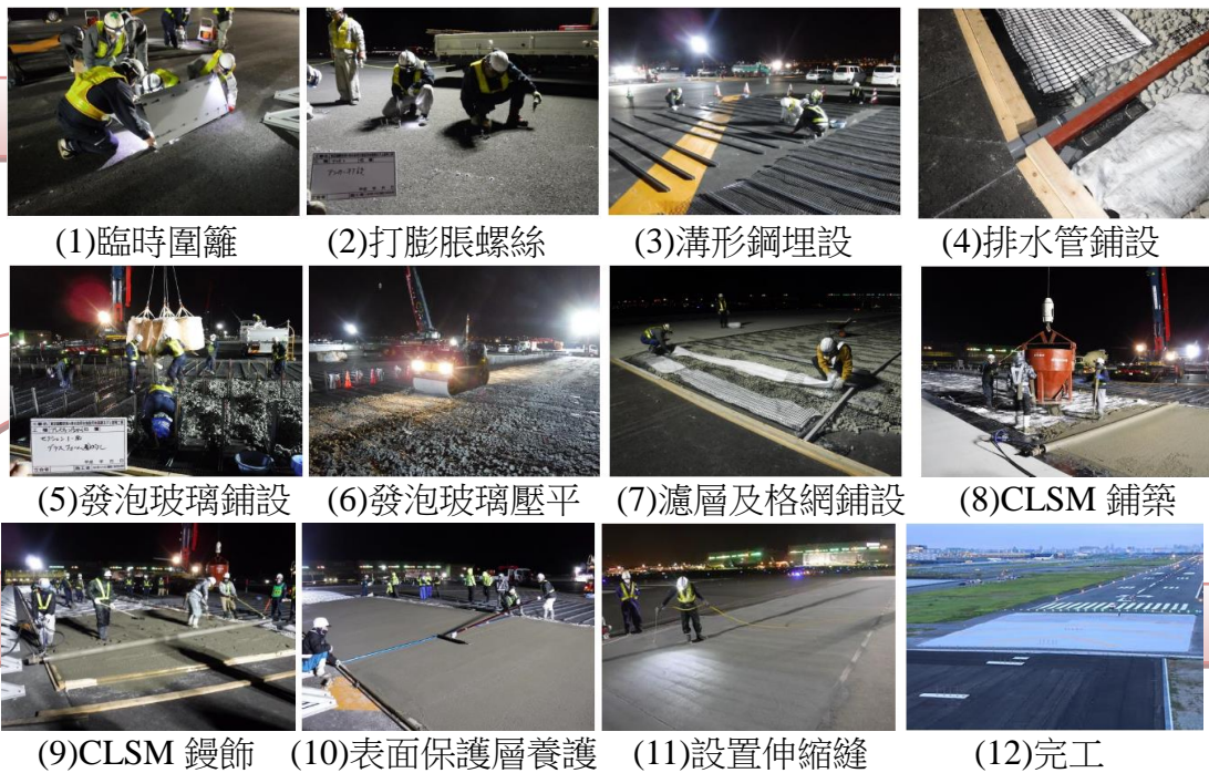
圖 3.2.14 Green EMAS 施工順序
