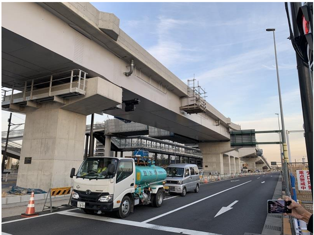
圖 3.3.18 環狀道路八號線施工相片
