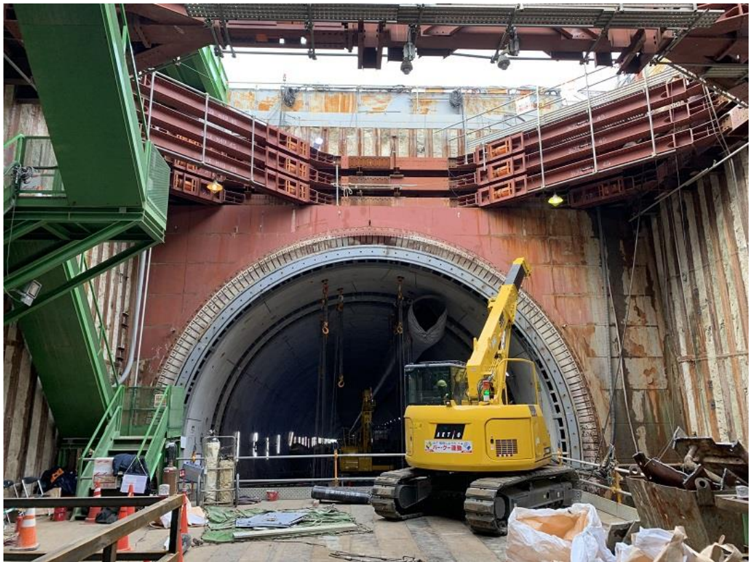
圖 3.3.4 國內線航廈與國際線航廈連通道施工相片
