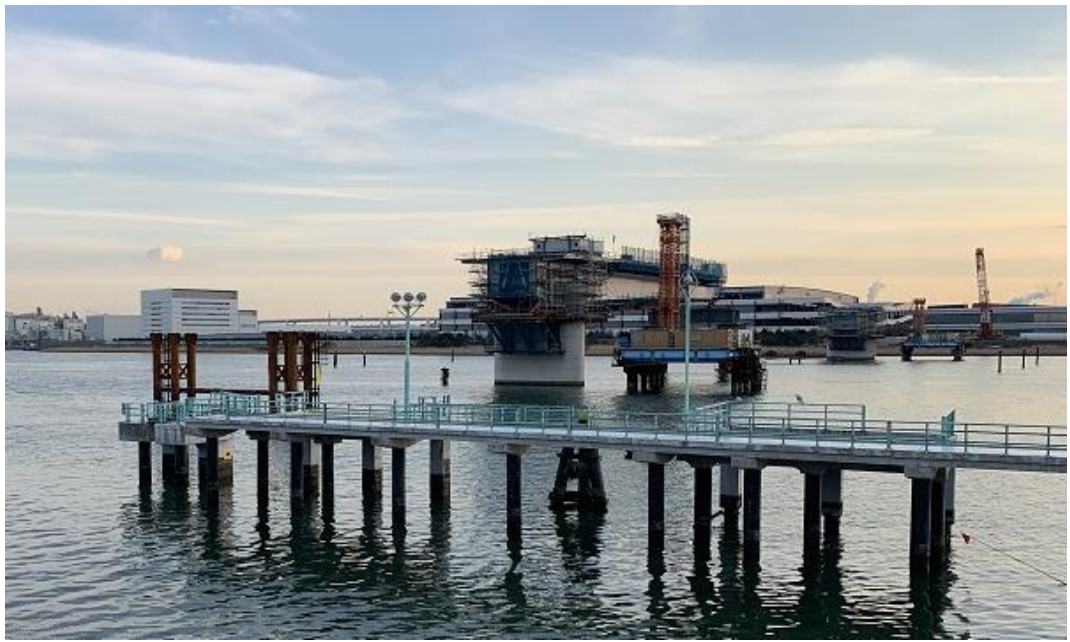
圖 3.3.17 羽田機場聯絡道路施工相片
