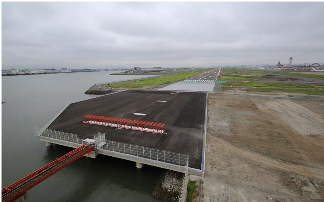
圖 3.3.8 A 跑道左右定位台及電波反射用地完工相片
