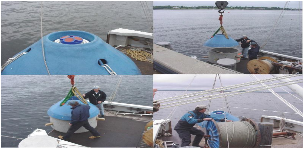
圖 15 底層錨定測流儀
