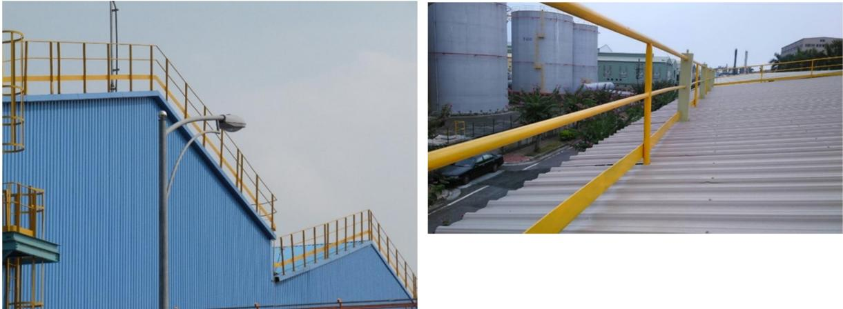
圖 3.5：降低屋頂邊緣作業風險的安全措施—護欄（OSHA, 2016）
