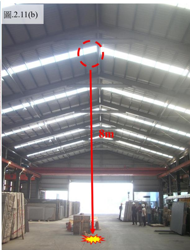
圖2.11：踩穿塑膠採光罩的營造作業死亡案例（OSHA, 2017a）：
