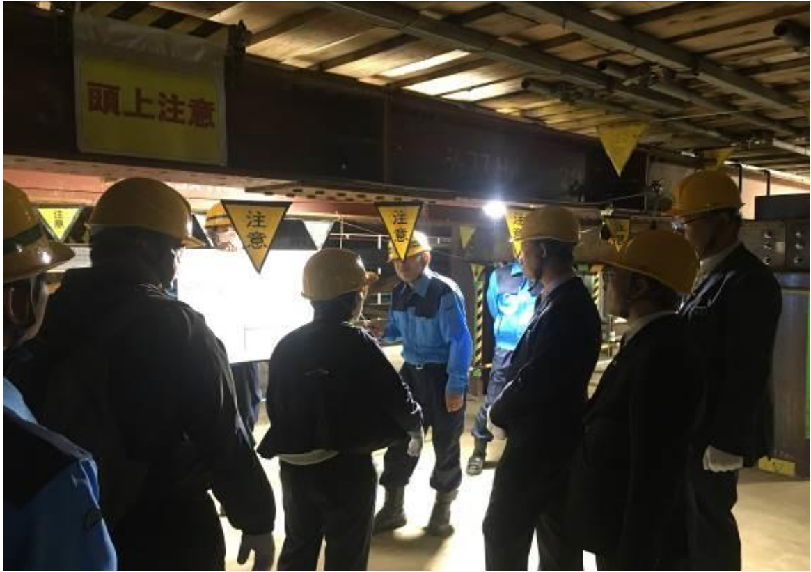
圖. 32 地下化工程現場勘查 1
