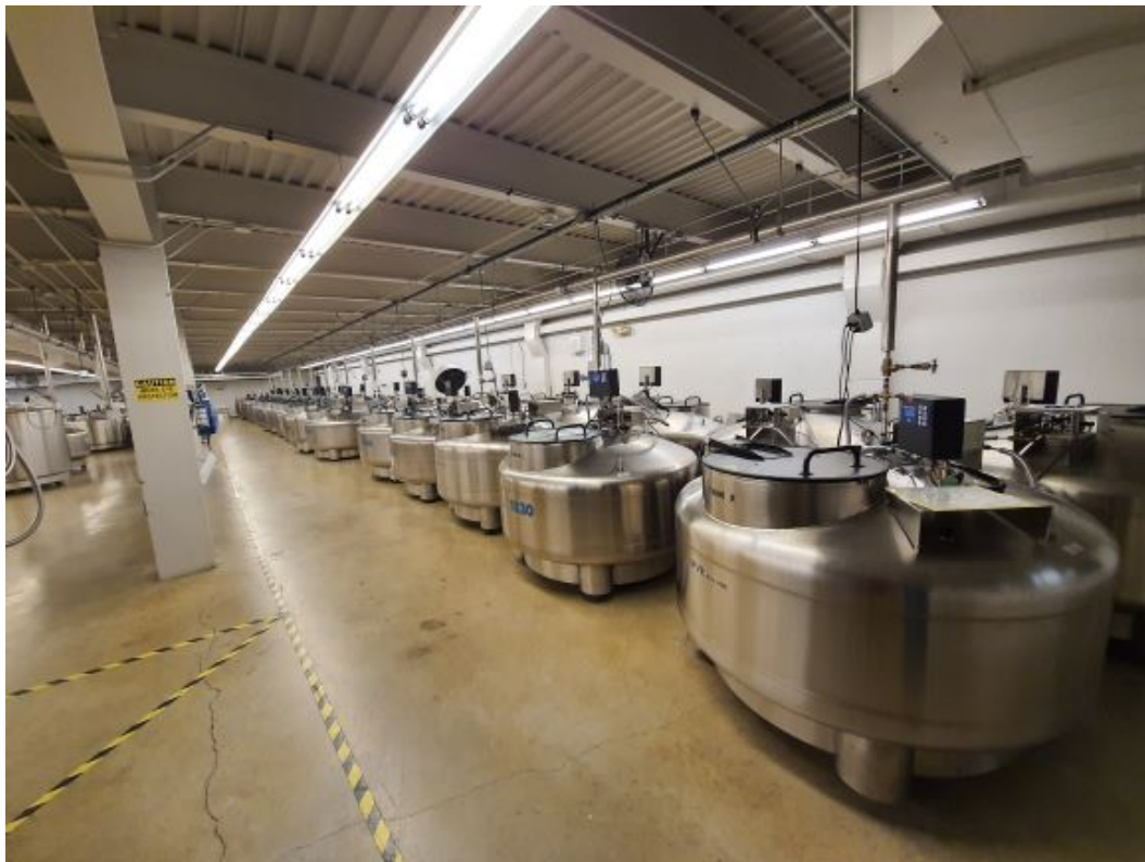
圖 4. NCGRP 建置有 220 個大型液態氮桶，可容納 3,000 件種子與 70,000 筆精液樣本。
