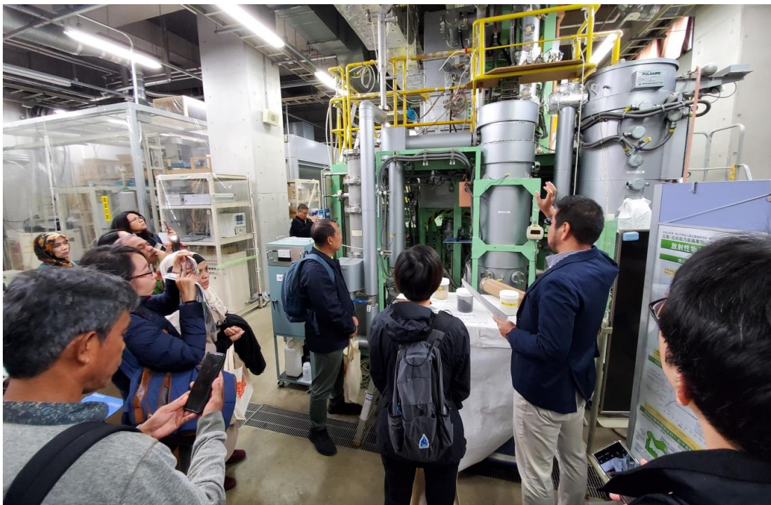
圖 39 熱處理小型煤廠外觀
