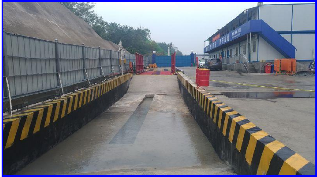
圖 3-3.6 工地出入口洗車台
