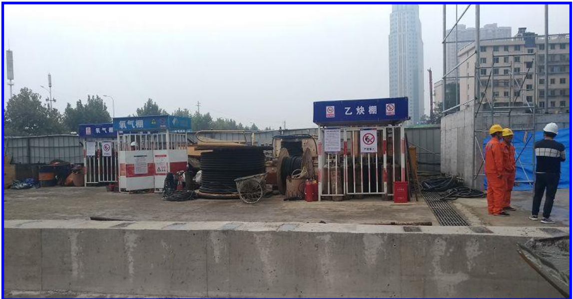
圖 3-3.5 工地物料及鋼瓶堆置區 (分類清楚並標示清楚)
