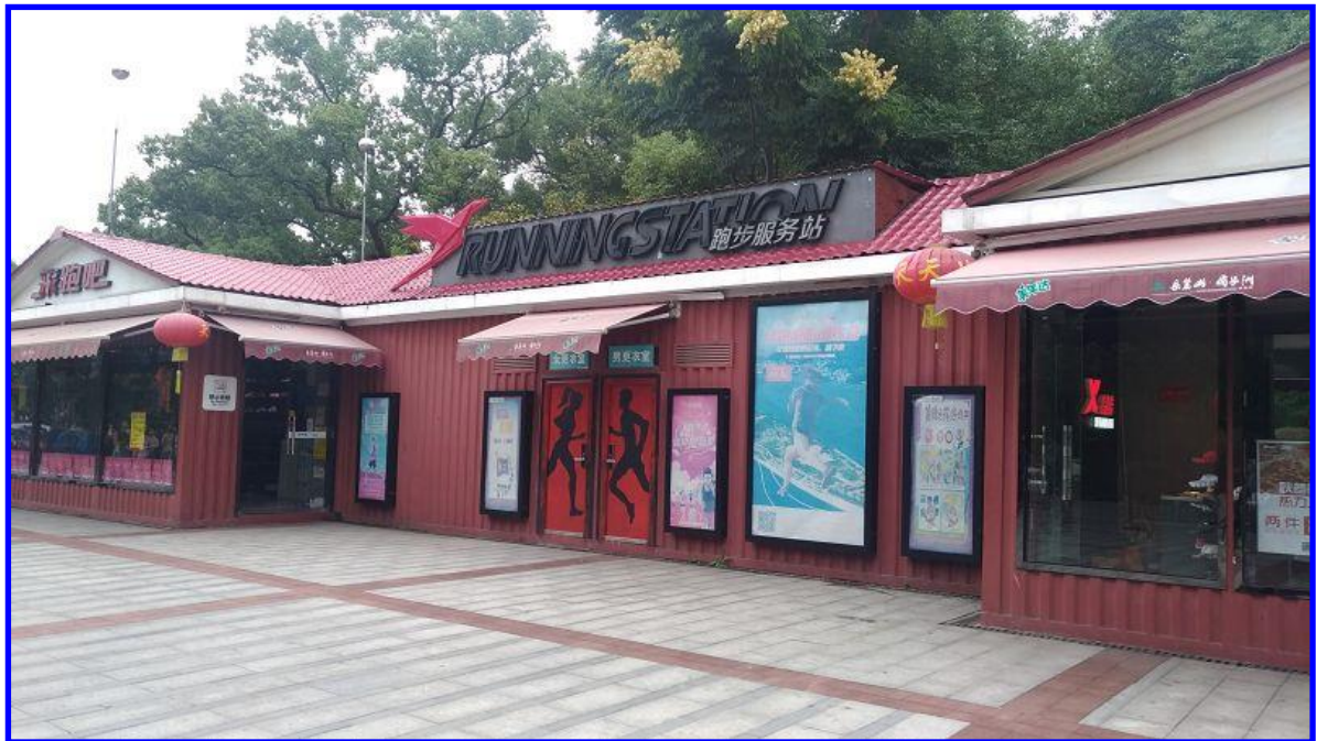
圖 3-2.10 橘子洲車站廣場
