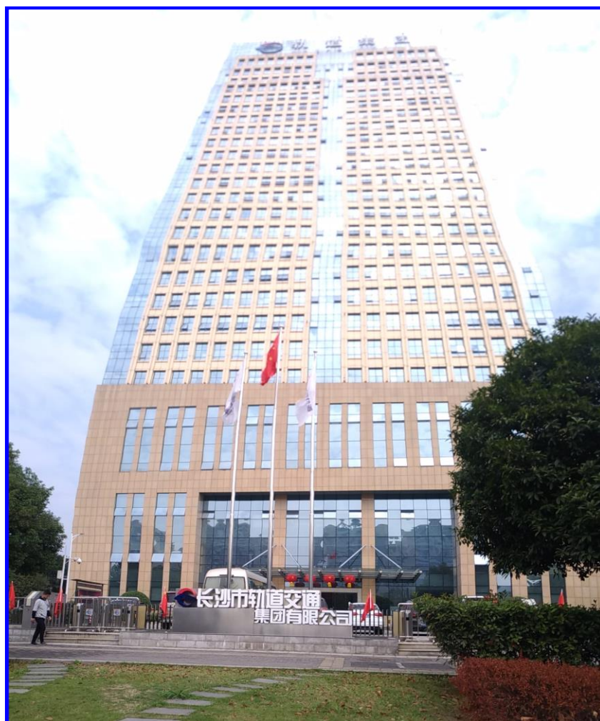
圖 4-3.1 長沙市軌道交通集團有限公司大樓外觀
