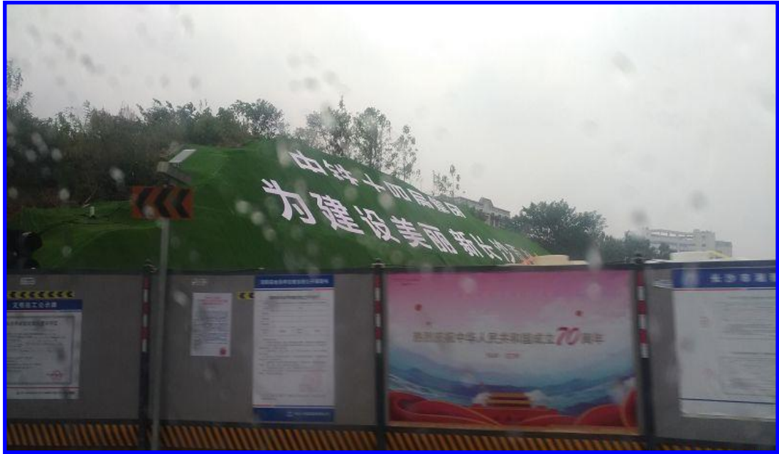
圖 3-3.4 工地圍牆及邊坡防護 (兼顧廣告標語及宣導)
