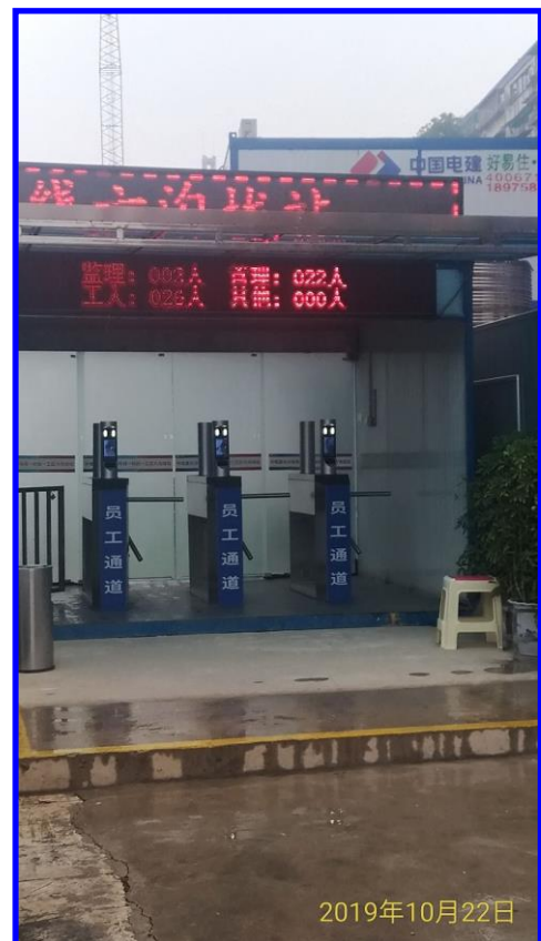
圖 3-3.10 工地人員控管
