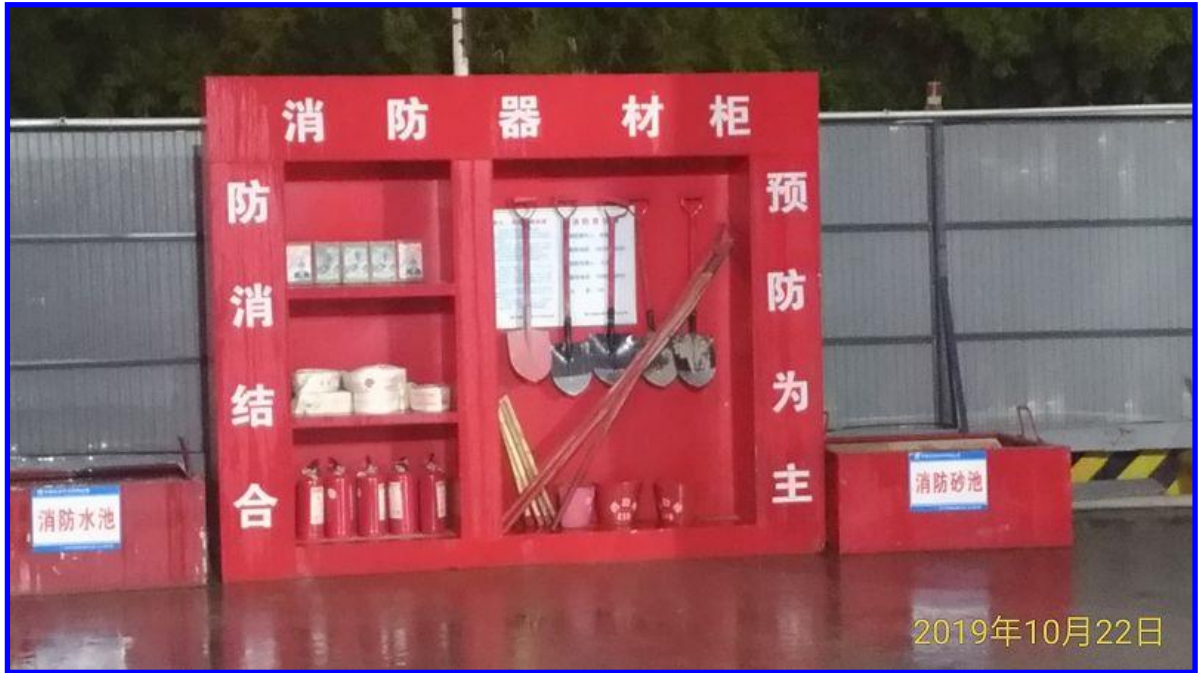
圖 3-3-19 工地消防設備集中放置
