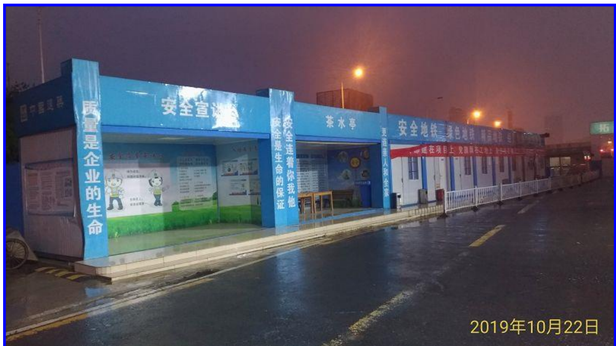
圖 3-3-20 進入工地工作前安全宣導區及休息空間
