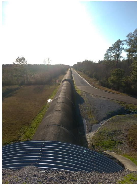
圖六：來到 LIGO 監測站，巨大的管子就是雷射來回反射的真空腔體，長達四公里
