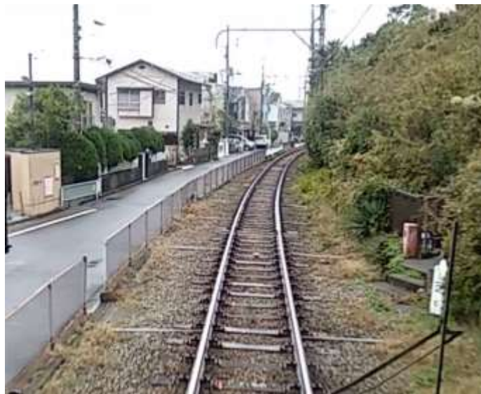
圖 3.2.3.2-5 鐵路專用路權段，路線和道路間設置柱狀圍籬及護欄予以隔離
