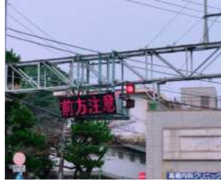
圖 3.2.3.2-2 共用路權段，設置電車接近顯示器
