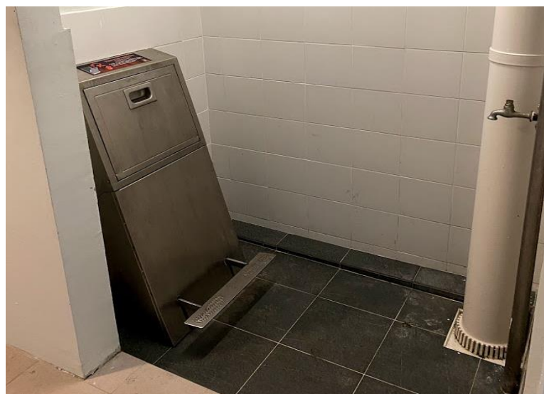
圖 2 新加坡組屋垃圾投放口設置
