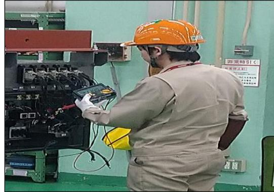
圖 3-32 測耐壓後的絕緣量測
