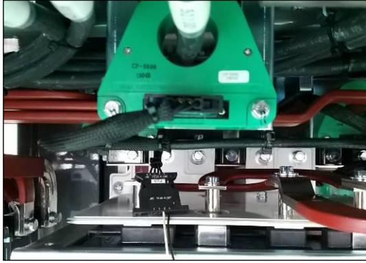
圖 3-51 CUT 測試
