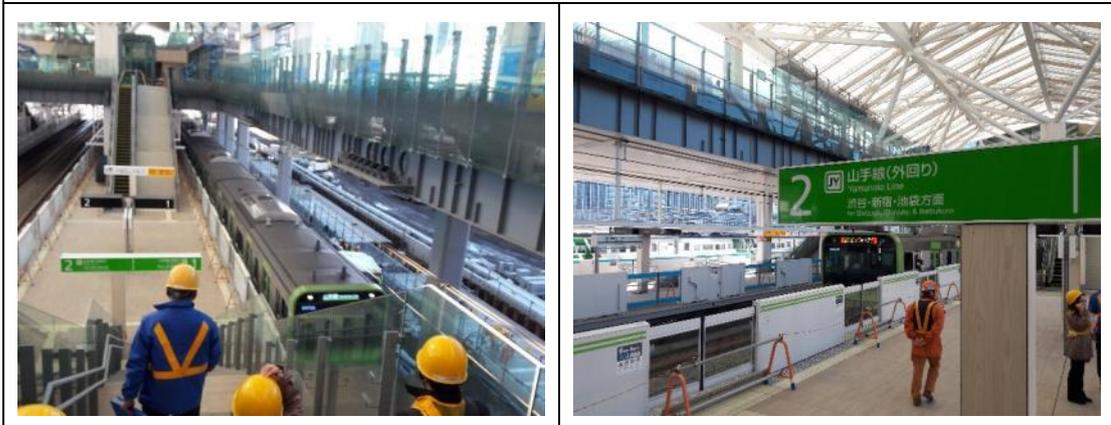
已於 2019.11.16 切換軌道通車，但車站未啟用，先建月台門兼施工圍籬。施工進度達九成，預定 2020 東京奧運前啟用車站。
