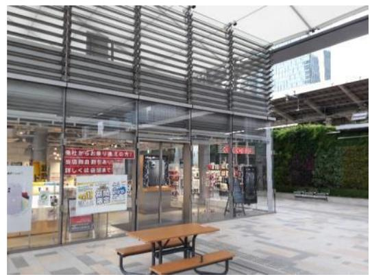
八重洲側新站斜屋頂，似為既有雨棚斜面之延伸。採帆布雨棚，可抗紫外線、採光、輕量，支撐柱非常苗條。與古蹟站隔著軌道群，兩者有一段距離，新 VS 舊之對話：現代感、輕巧、灰色低調、金屬帆布下之虛空間 VS 厚重紅磚實體古蹟構造，這與臺中新站之思維類似。若採仿製舊站造型，可能會搶了舊站的風采。
