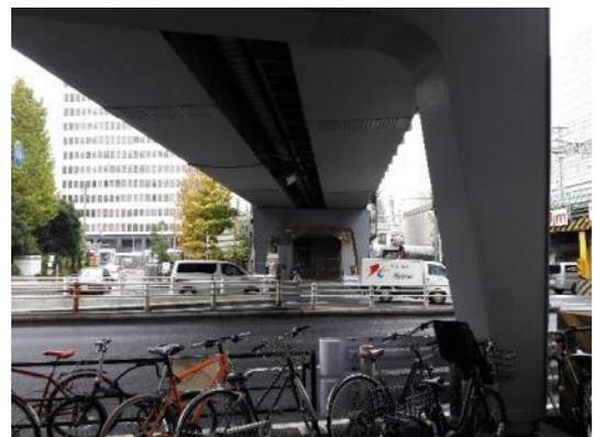
鐵路橋梁之門架式橋墩，上寬下窄，減少下方阻礙，值得借鏡。
