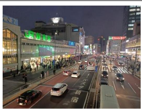
Busta (バスタ) 新宿是位於新宿站南口的大眾運輸轉運設施，主要為提供與集中新宿站周圍的高速巴士（長途客運）、計程車搭乘站點而建造，是日本最大的客運總站。建設時以人工地盤方式建置在火車上方，廣達 1.47 公頃(右圖可看到進轉運站之專屬車道)。工程委託給 JR 東日本施作，2006 年 4 月 8 日動工，2016 年春季完工，同年 4 月 4 日正式啟用。
