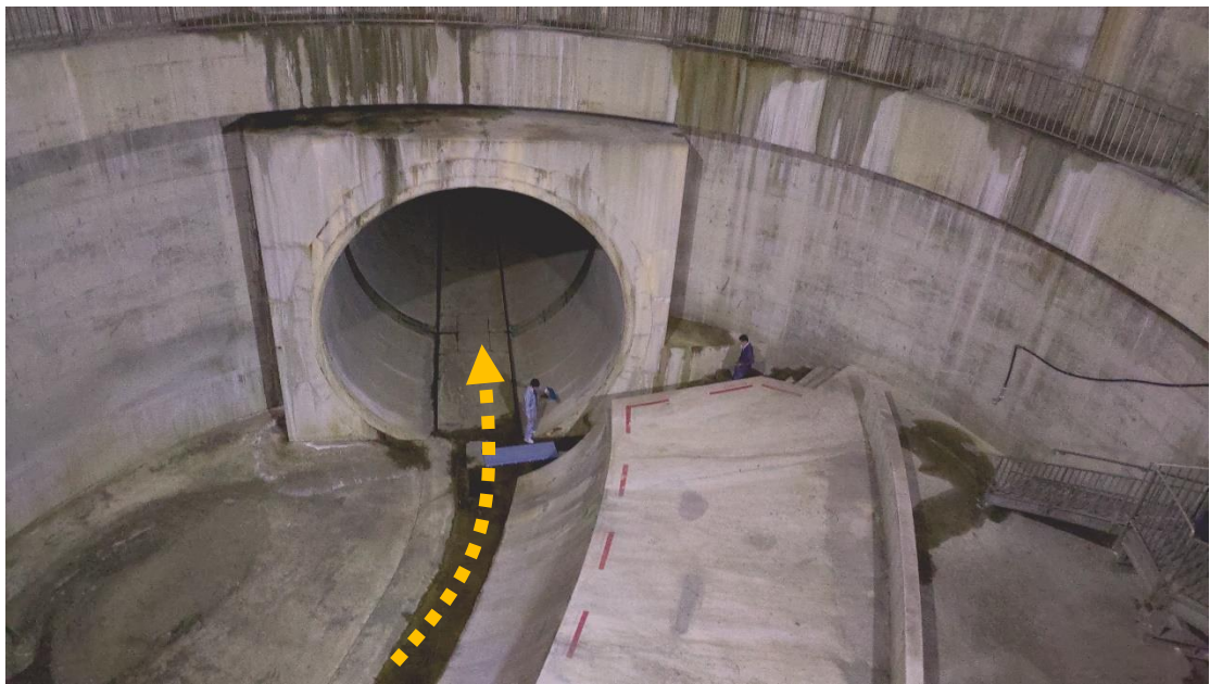
圖 18 若江立坑現場照片
