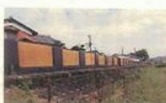
掛保川 疊堤(1947年豪雨時の設置状況)
