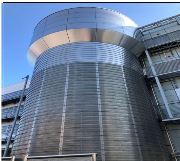
21 公尺深潛水大樓
