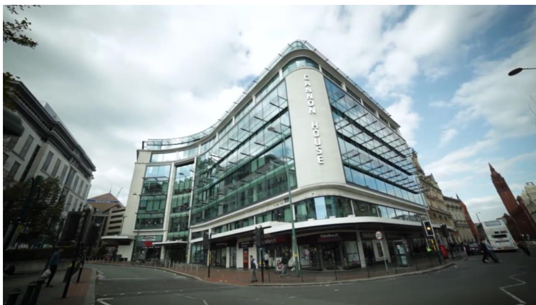
圖 17 本次參訪之 Energy Systems Catapult Cannon House
