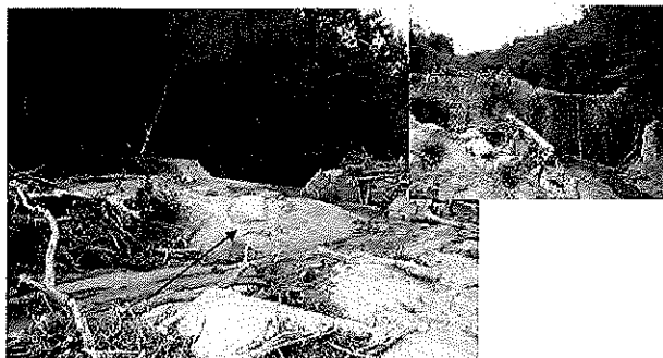
長谷川(A)3号砂防堰堤(石積) 堤高H=4.8m, 堤長L=41.4m, 幅W=1.5m 竣工:不明
