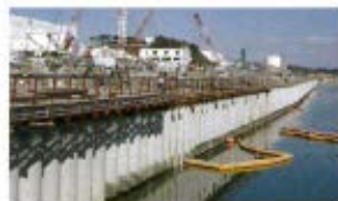
圖三 1F4個反應爐機組外觀及預防地下水滲透之圍堵設施
