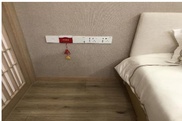
臥室、客廳、衛生間等多個地方均有安裝一鍵緊急呼叫紅色按鈕，以確保老人幫助或遇到突發情況時能夠第一時間聯繫到工作人員
