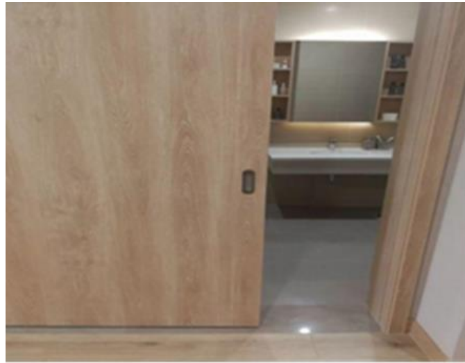
採用開口較寬的單扇移門，同時每扇門都要比常規的門寬出 10 公分，方便擔架或者輪椅老人進出/雙人套房
