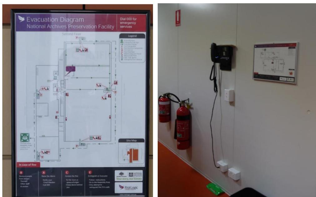
圖 3-27 NAPF 一般庫房設置詳盡逃生說明、通信設備、手持滅火器(來源：自行拍攝)
