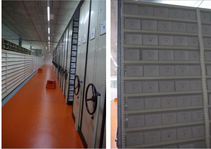
圖 3-37 NAPF 檔案庫房建置密集式書架背面設有通風細孔網(來源：自行拍攝)
