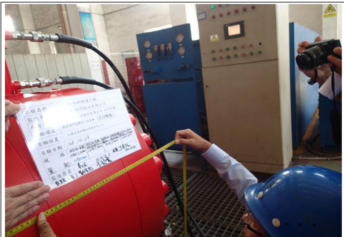
日期：108.10.29 尺寸檢查:油壓缸尺寸檢查(一) 地點：武進液壓啟閉機公司製造廠
