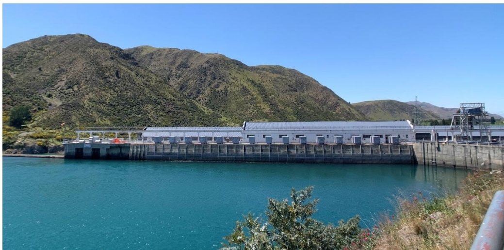
圖33、懷塔基水力發電站(2)
