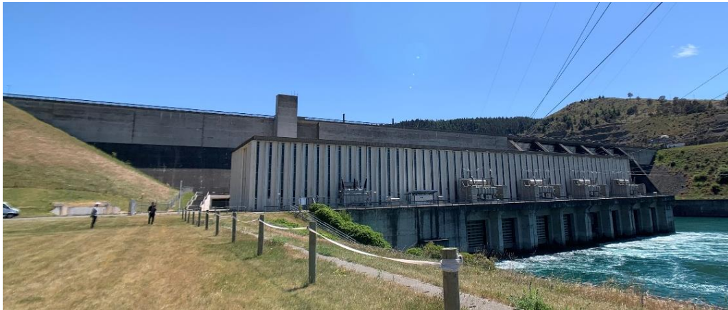
圖29、阿維莫爾水力發電站(1)
