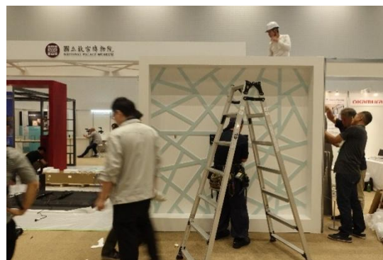
現場木工製作及展場 8K 螢幕的吊掛工作實況
