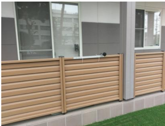
圖17. 外部架設麥克風設備
