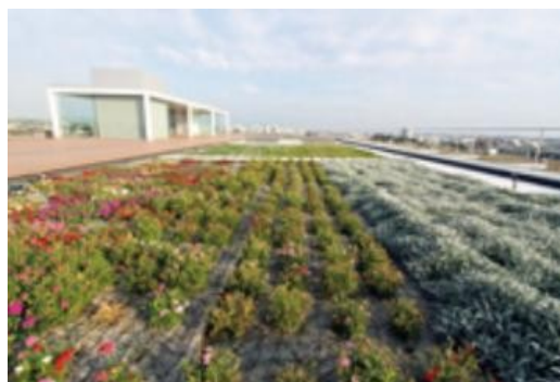
圖60 屋頂綠化[鹿島技術研究所]
