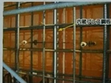
内蔵プレス鋼板施工例 (立面) Construction Example
