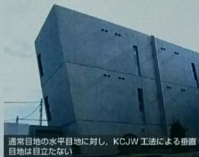
KCJW 工法による外壁の外観 Building Facade with KCJW Element
