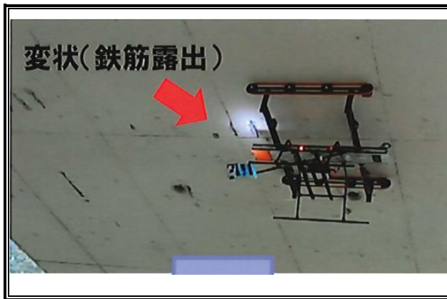
圖 3-9 無人機橋梁檢測
