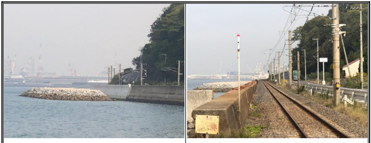
圖 3-23 予贊線海岸寺詫間護岸以塊石填築便道施工
