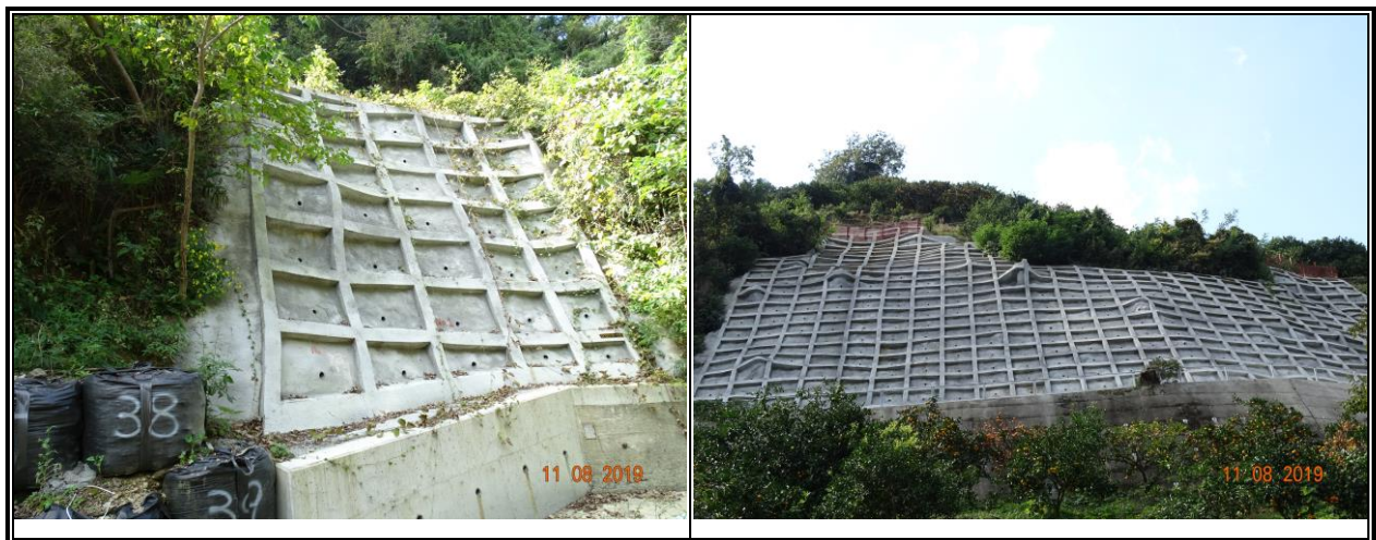
圖 3-38 格子梁護坡工程
