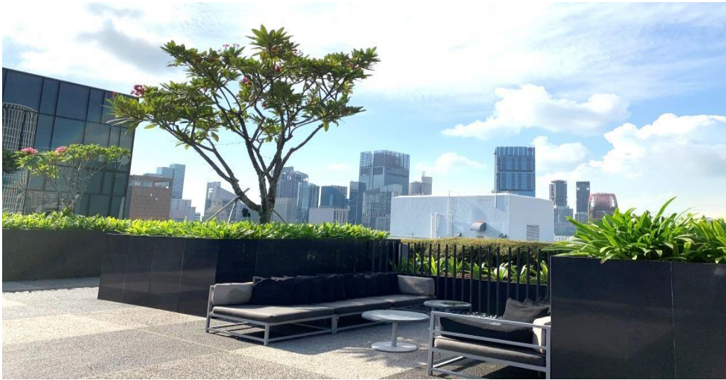
圖 53 頂樓 16 樓採用透水磚收集雨水
