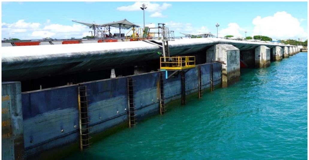
圖 47 濱海堤壩閘門
