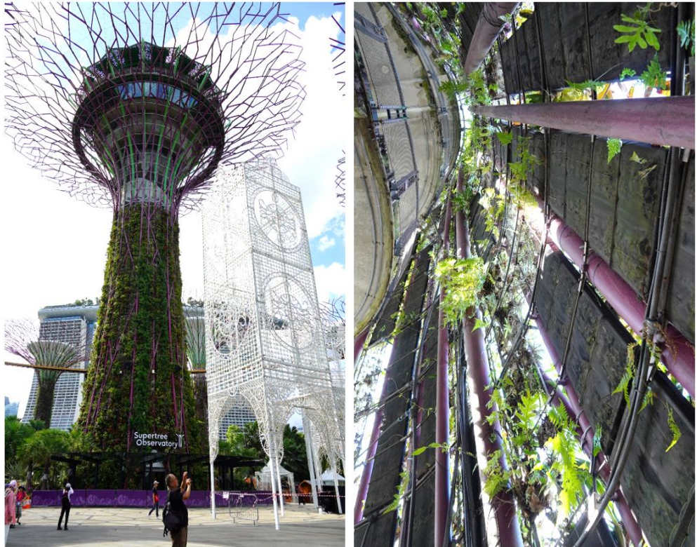
圖 50 左：天空步道入口 右：擎天巨樹樹幹內部結構
