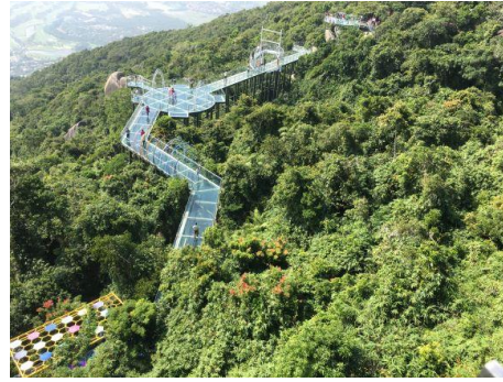
圖 79、園區內玻璃橋
